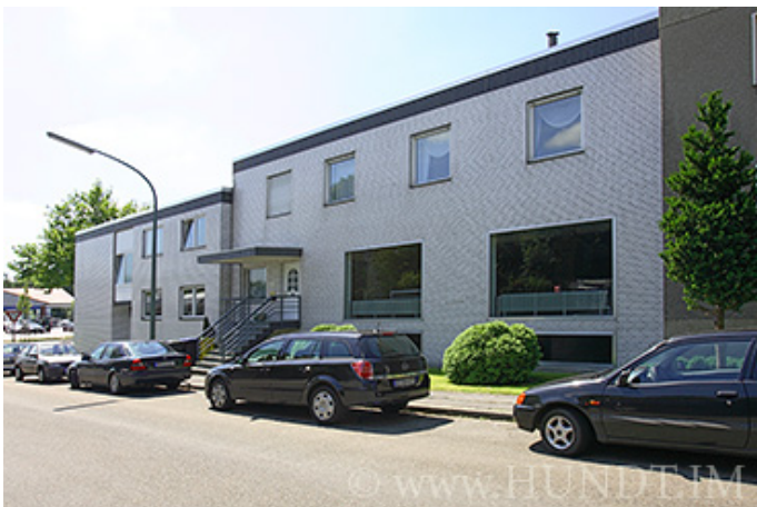
Seitenansicht der Gebäude
